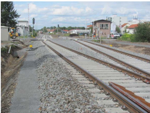
Bf Grimma, BÜ km 19,3 nach Umbau
